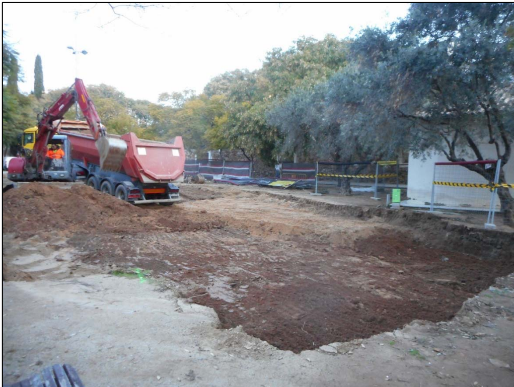
6. Inici de les actuacions de rebaix de terreny a l'àmbit dels Jocs Infantils.
