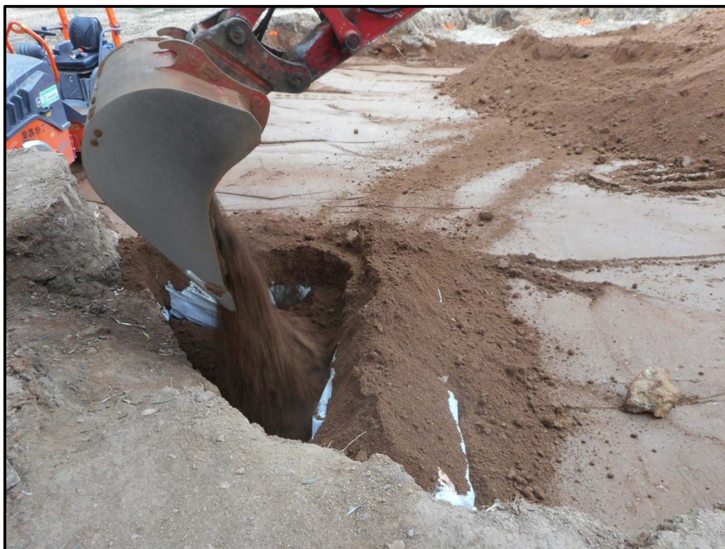
43. Tasques de cobriment de l'estructura UE007-014.
