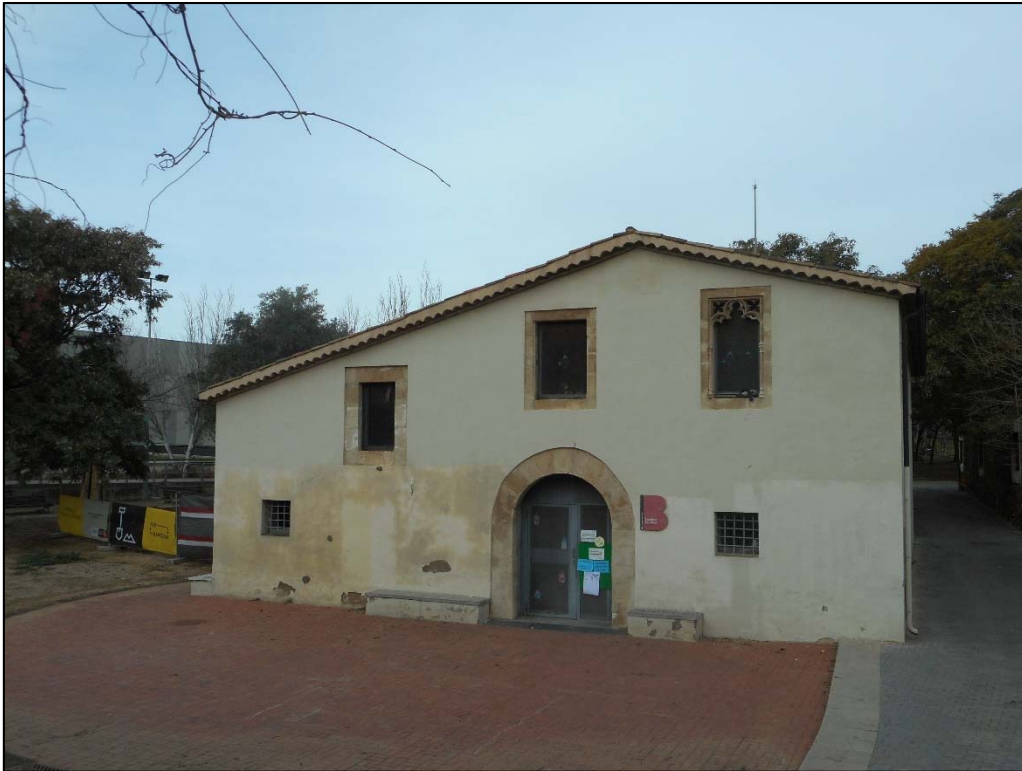
1. Aspecte actual de la façana de la masia de Ca l'Arnó.
