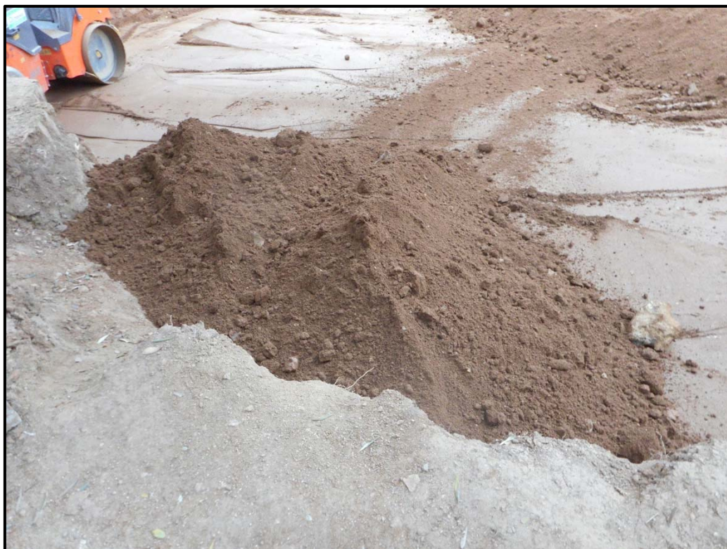
44. Cobriment de l'estructura UE007-014.
