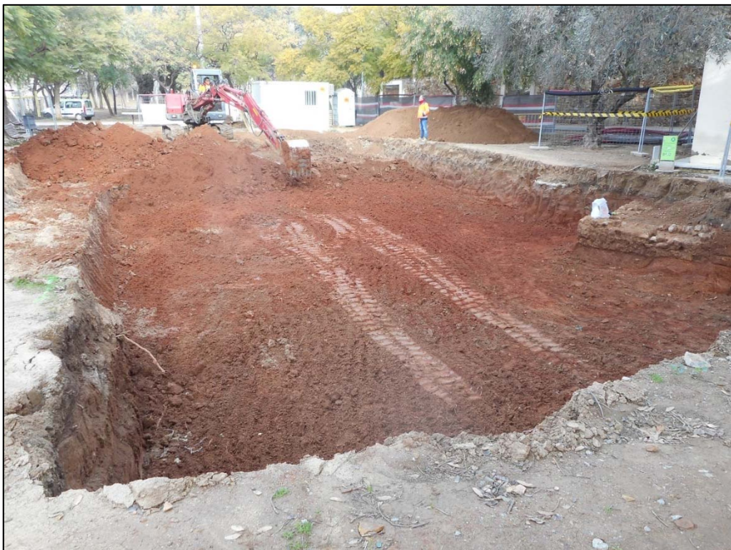
36. Màquina realitzant treballs d'extracció de terres.
