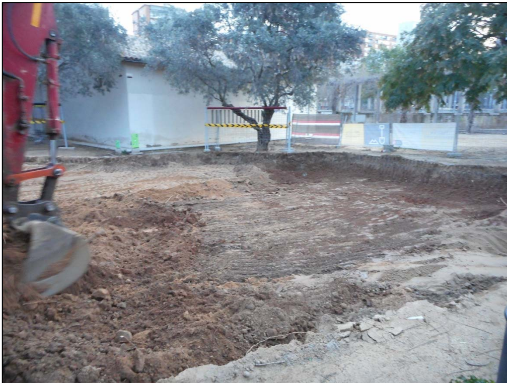
4. Inici de les actuacions de rebaix de terreny a l'àmbit dels Jocs Infantils.
