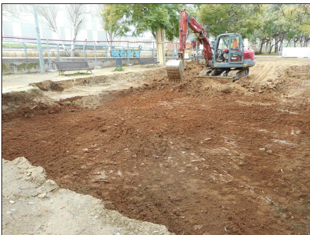
28. Màquina realitzant treballs d'extracció de terres.
