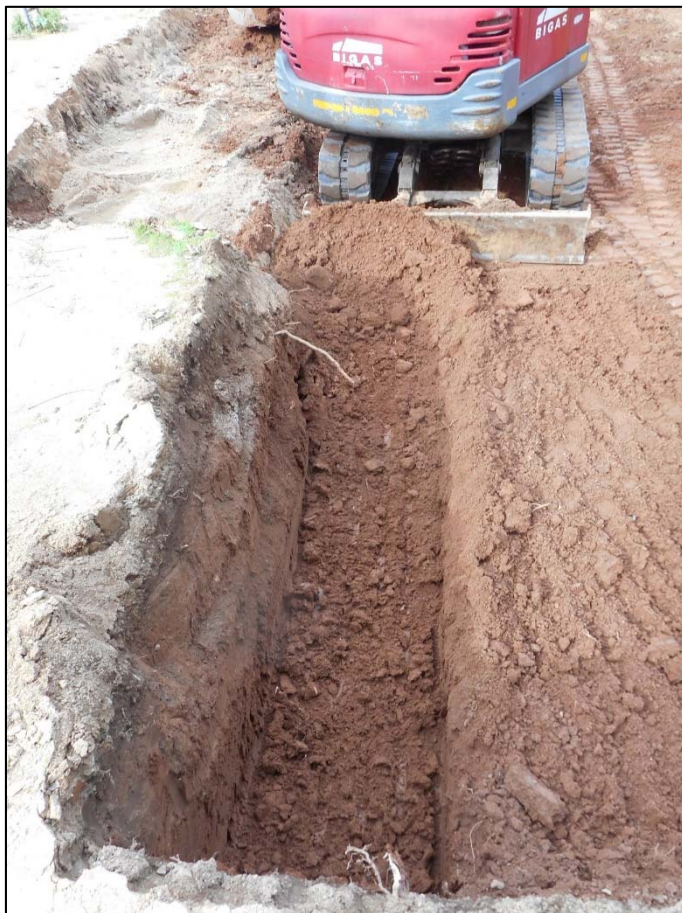
29. Màquina realitzant treballs d'extracció de terres.
