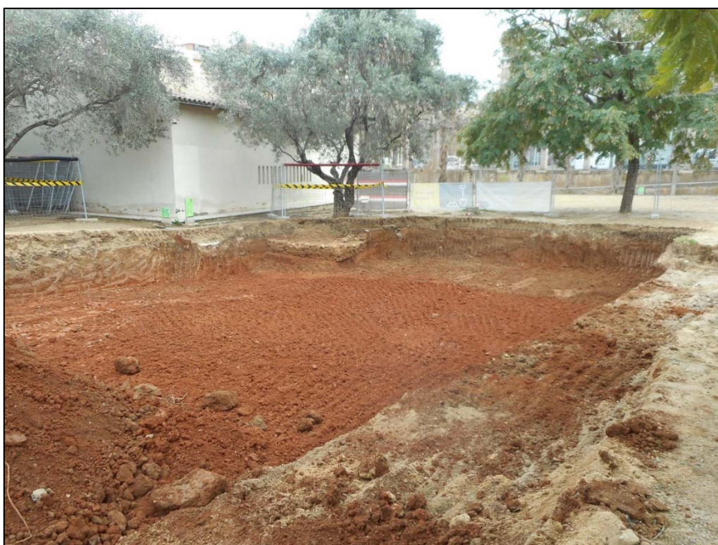
38. Màquina realitzant treballs d'extracció de terres.
