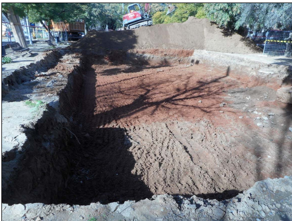
40. Àmbit d'actuacions d'extracció de terres, FINAL.
