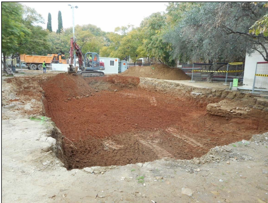
37. Màquina realitzant treballs d'extracció de terres.
