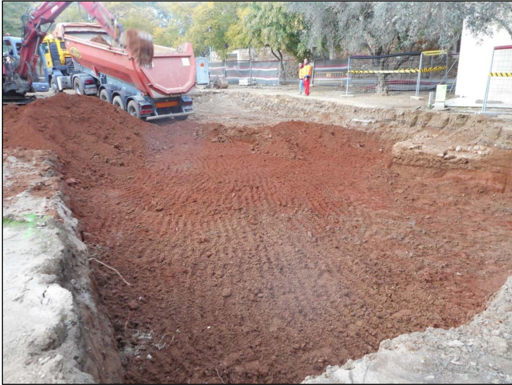
35. Màquina realitzant treballs d'extracció de terres.
