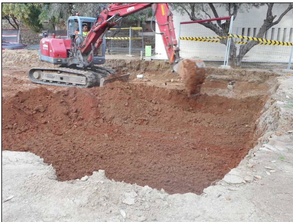
30. Màquina realitzant treballs d'extracció de terres.
