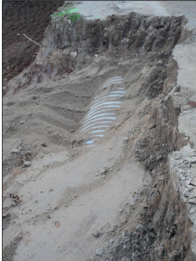
5. Canalització contemporània present al límit Oest de l'àmbit d'actuacions.
