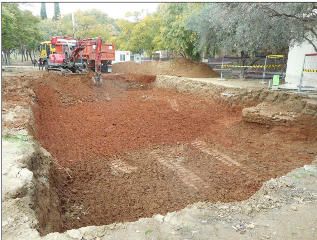
39. Màquina realitzant treballs d'extracció de terres.
