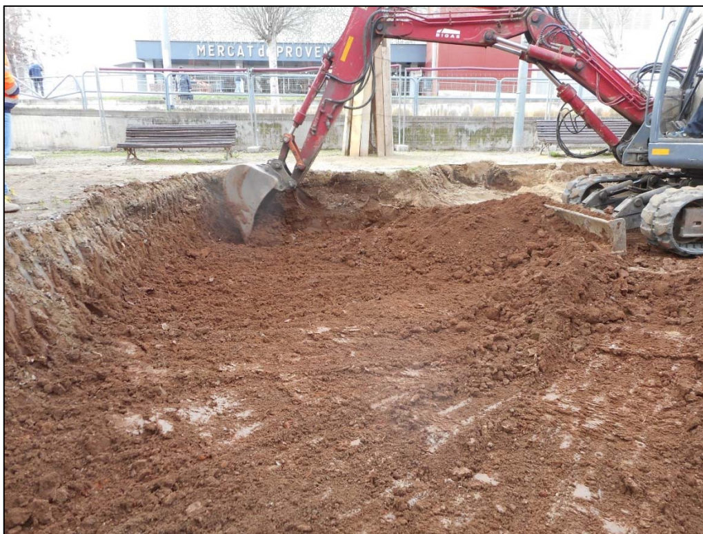
27. Màquina realitzant treballs d'extracció de terres.
