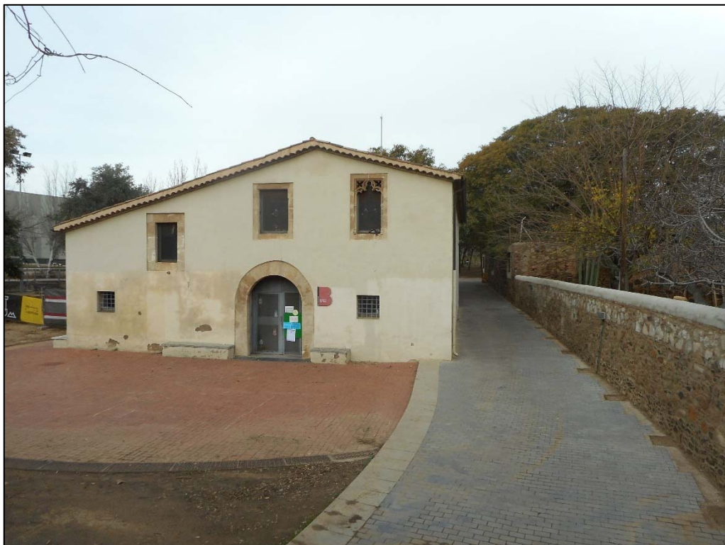
2. Aspecte actual de la façana de la masia de Ca l'Arnó. Mur lateral de compartimentació amb la masia de Can Cadena, àrea cementirial de Sant Martí de Provençals.
