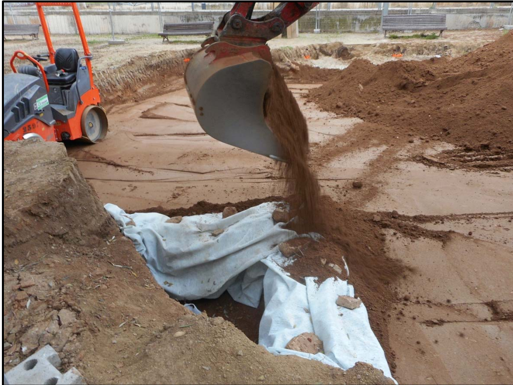
42. Tasques de cobriment de l'estructura UE007-014.
